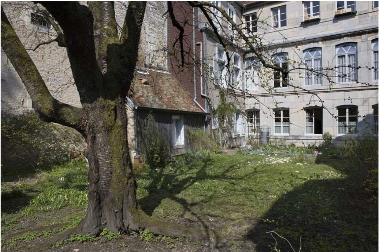
Vue partielle de la façade postérieure du logis secondaire depuis le fond du jardin.
