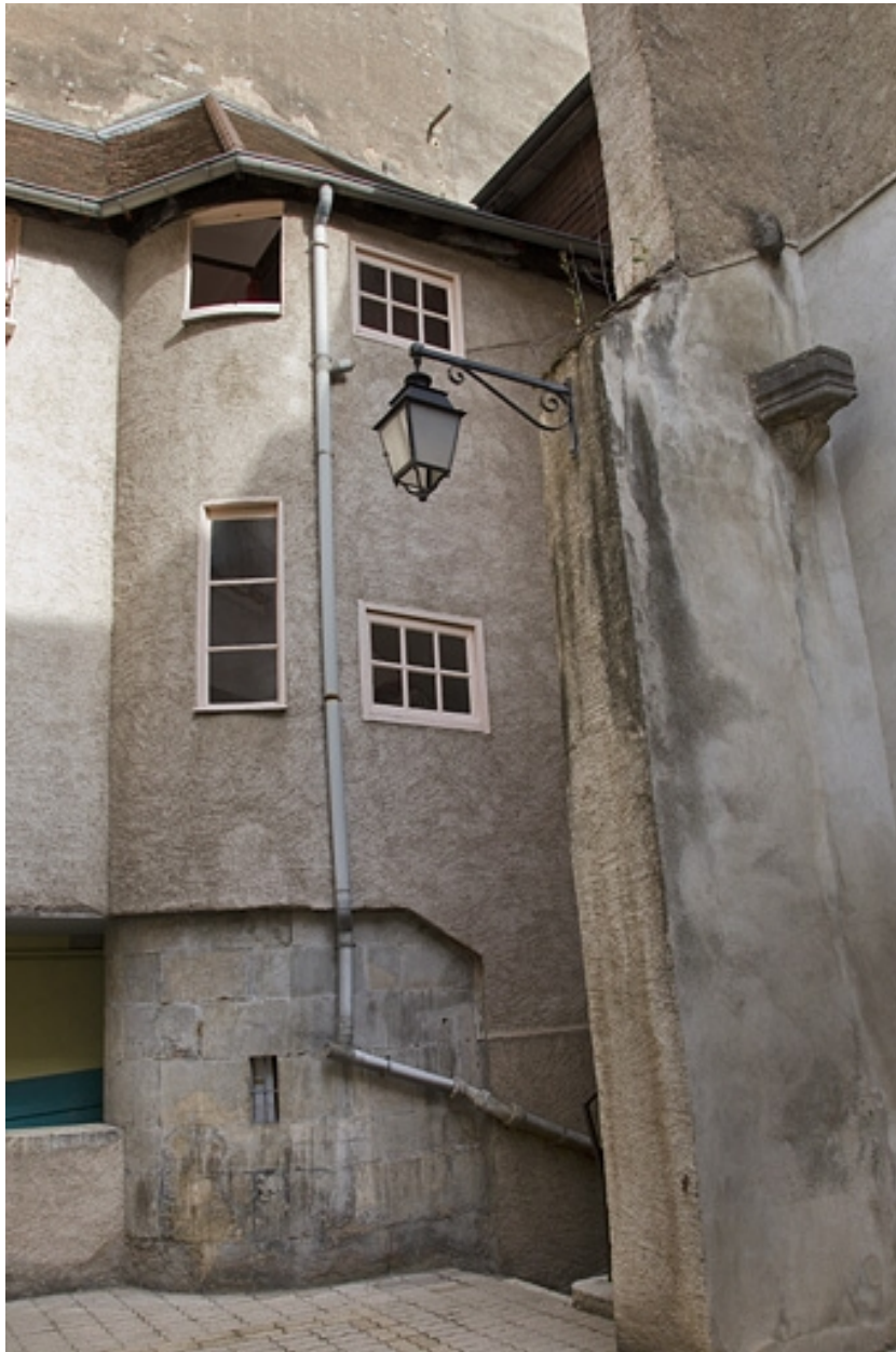
Escalier à cage ouverte : détail de la partie droite depuis la cour.
