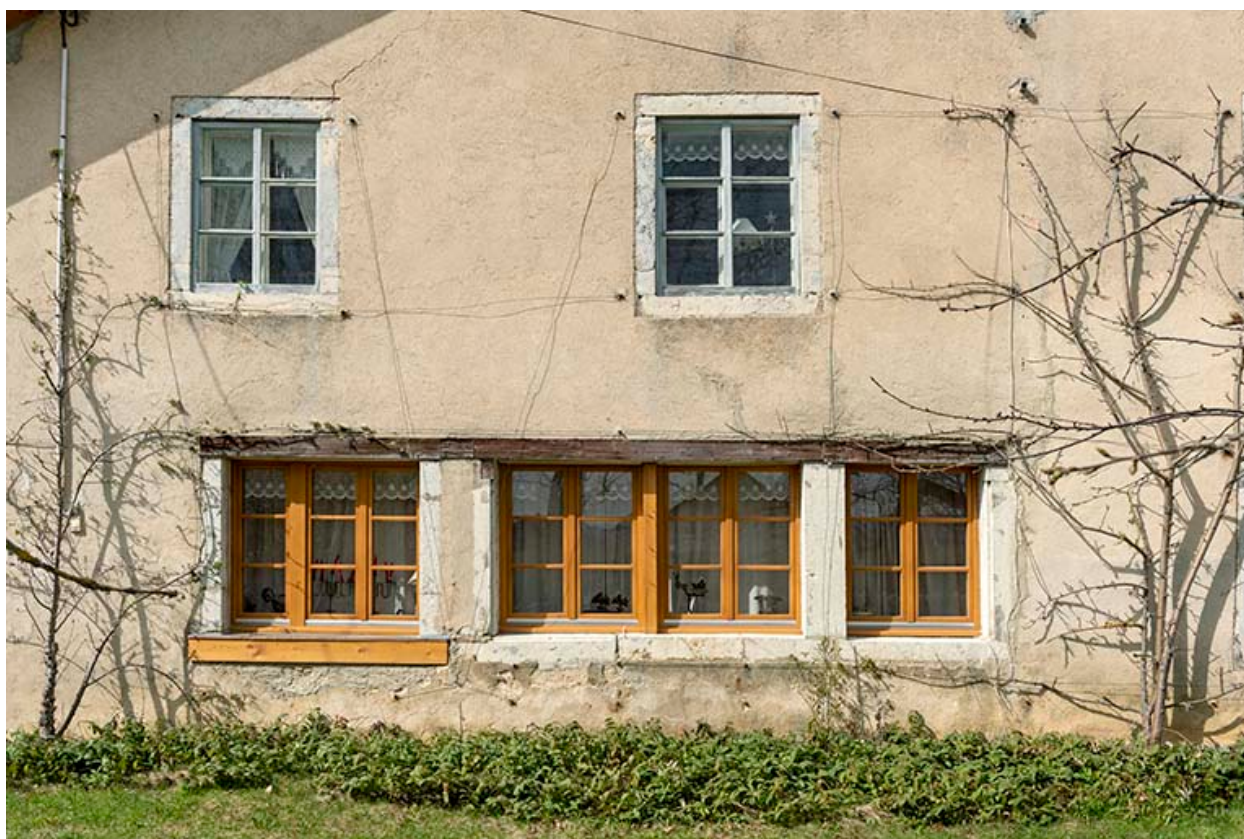
Façade sud : fenêtre multiple de l'atelier.
