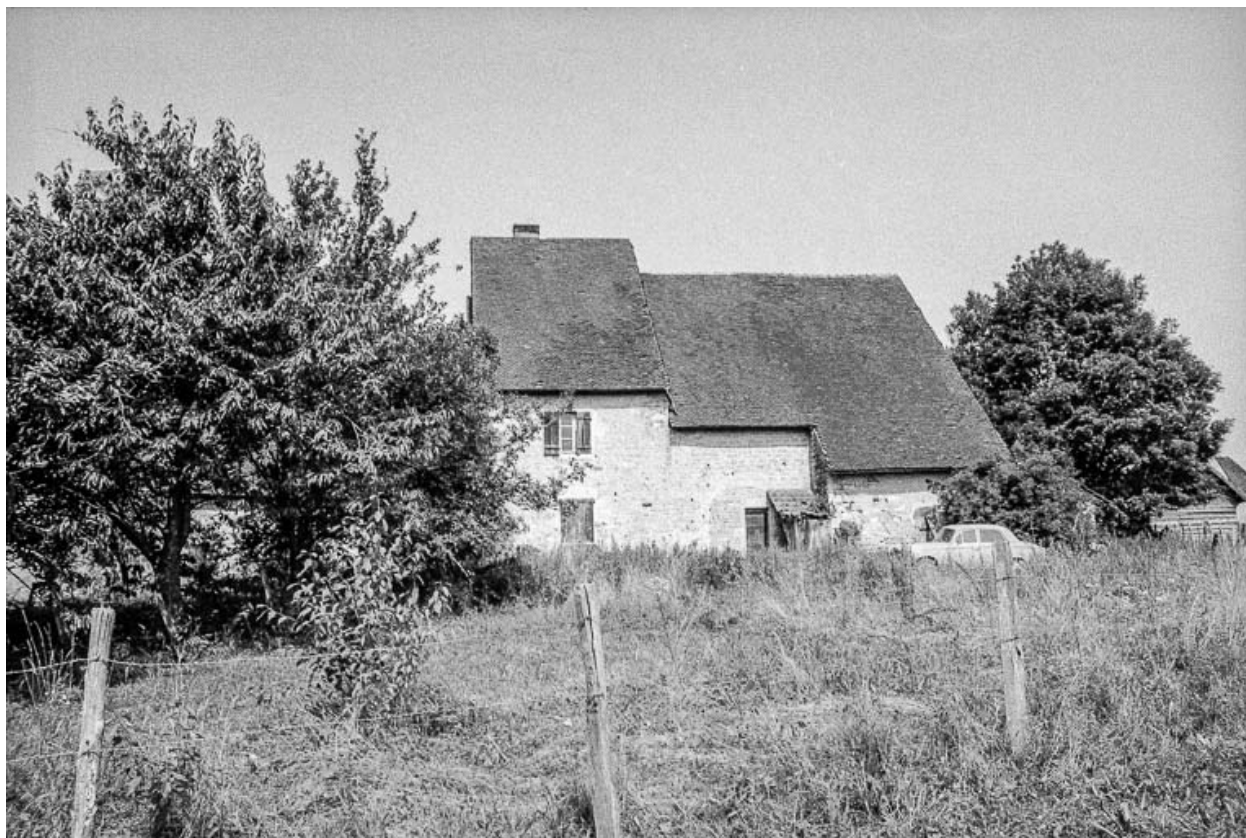
Façade postérieure en 1975.
