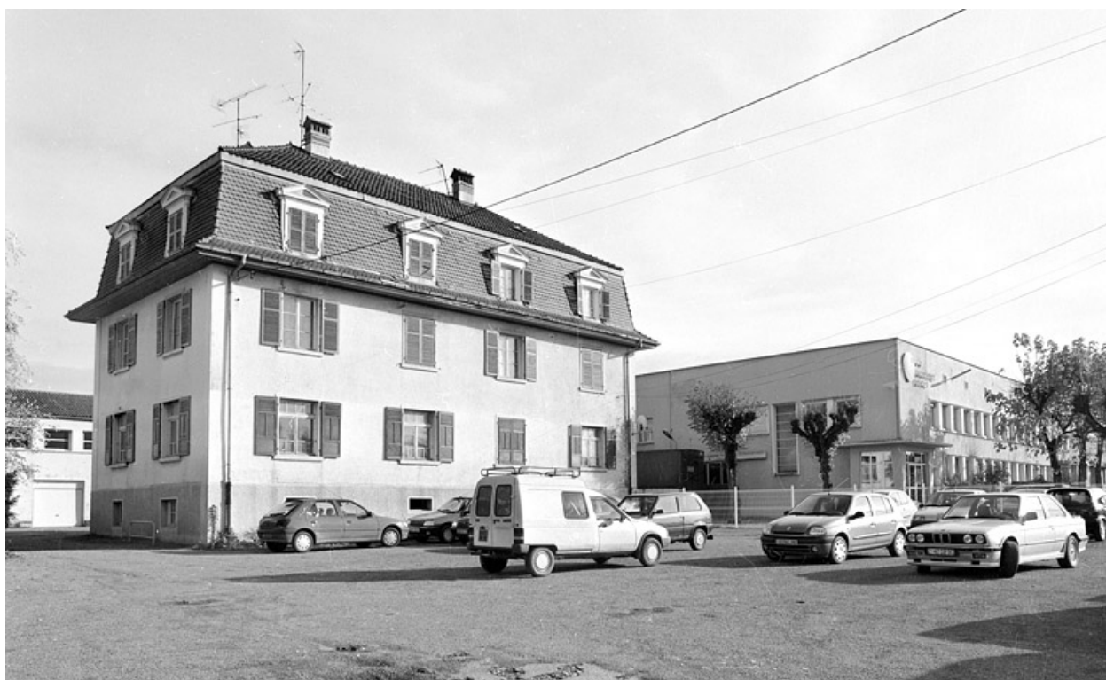
Logement (anciens bureaux) et atelier de fabrication.
