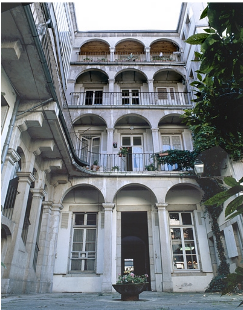
Façade sur la cour.
