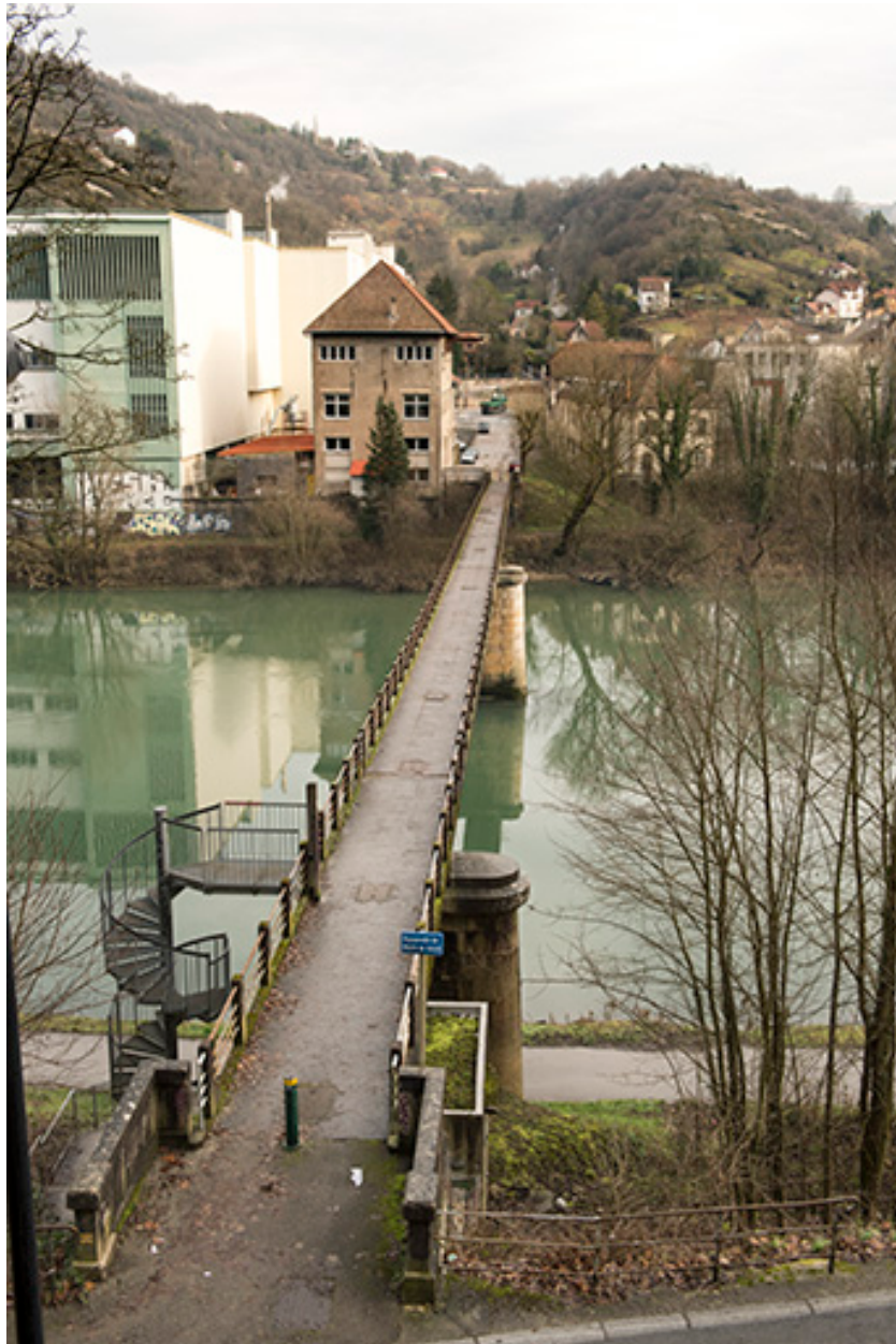
Etat en 2016. Usine B : transformateur et passerelle, depuis la rive gauche du Doubs.
