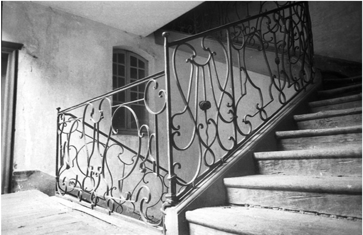
Cage d'escalier. Le troisième étage, s.d. [vers 1960].
