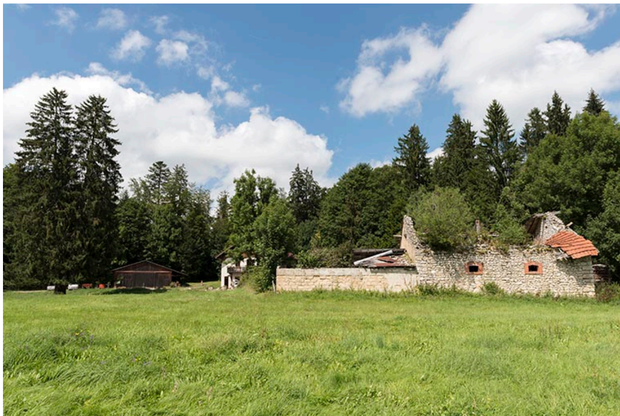
Vestiges de la porcherie, depuis le sud.
