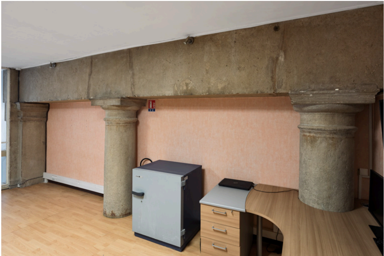
Partie supérieure et chapiteau d'un pilastre et de deux colonnes dans l'ancienne halle.
