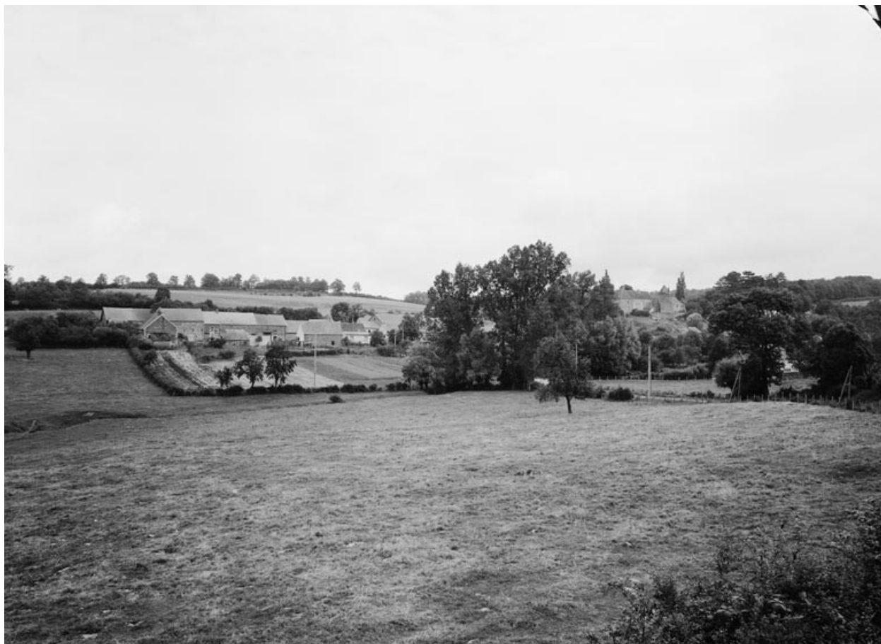
Vue d'ensemble du site de Jours-en-Vaux.
