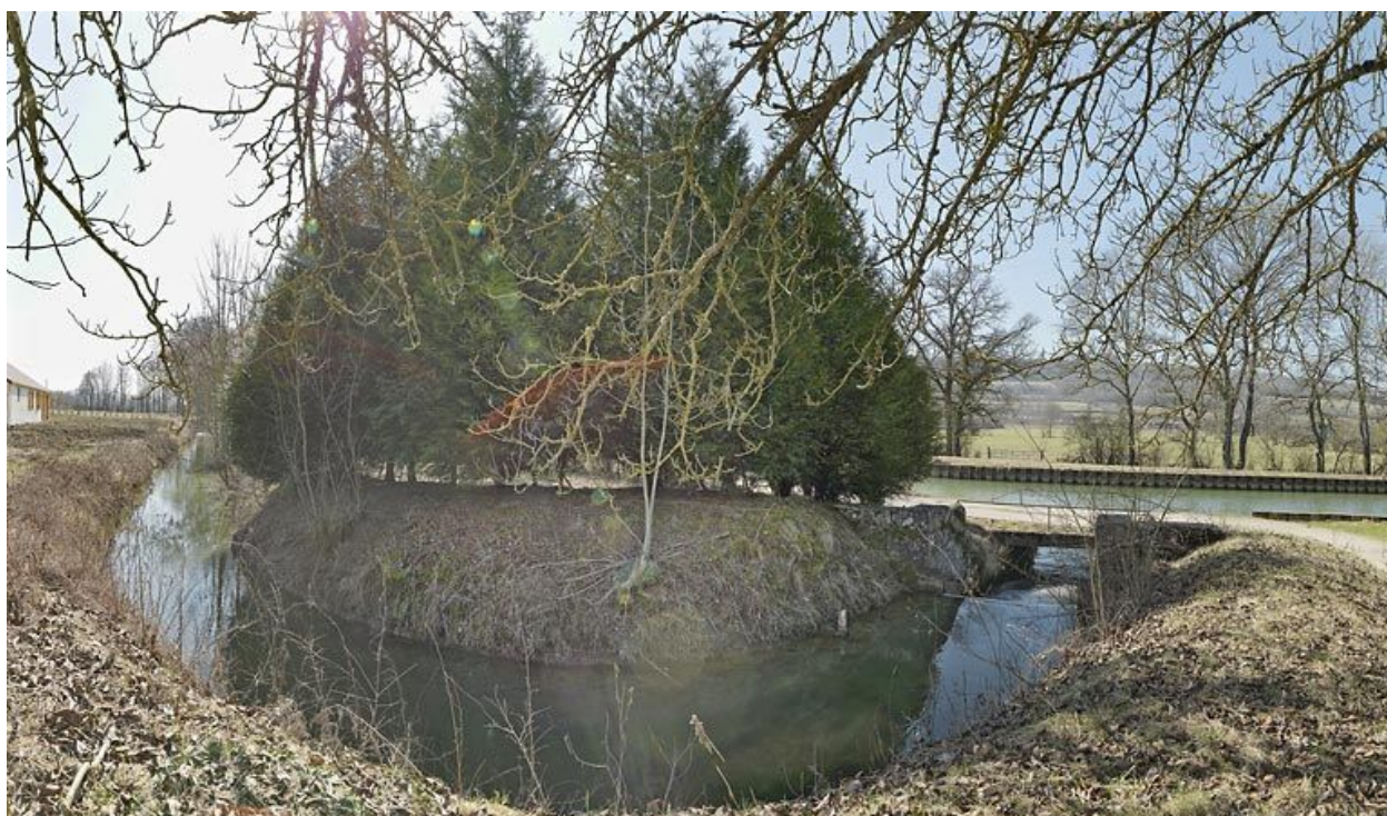
Arrivée au canal de la rigole d'alimentation.
