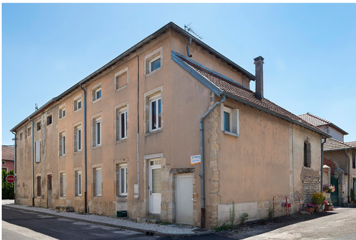
Élévation extérieure sur la rue des Fours.
