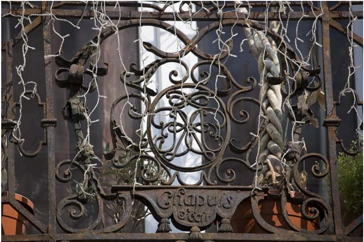
Détail de la grille du balcon : premier étage sur rue.
