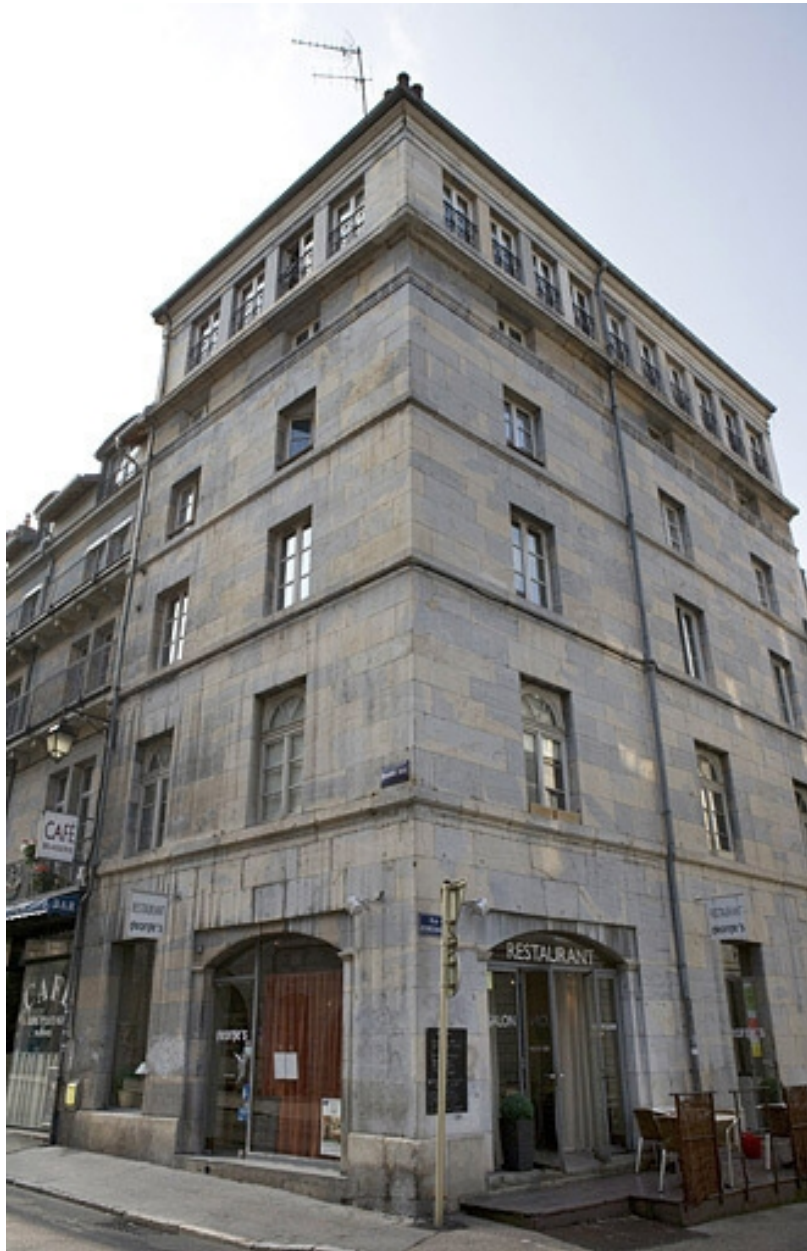
Vue d'ensemble de l'immeuble d'angle.
