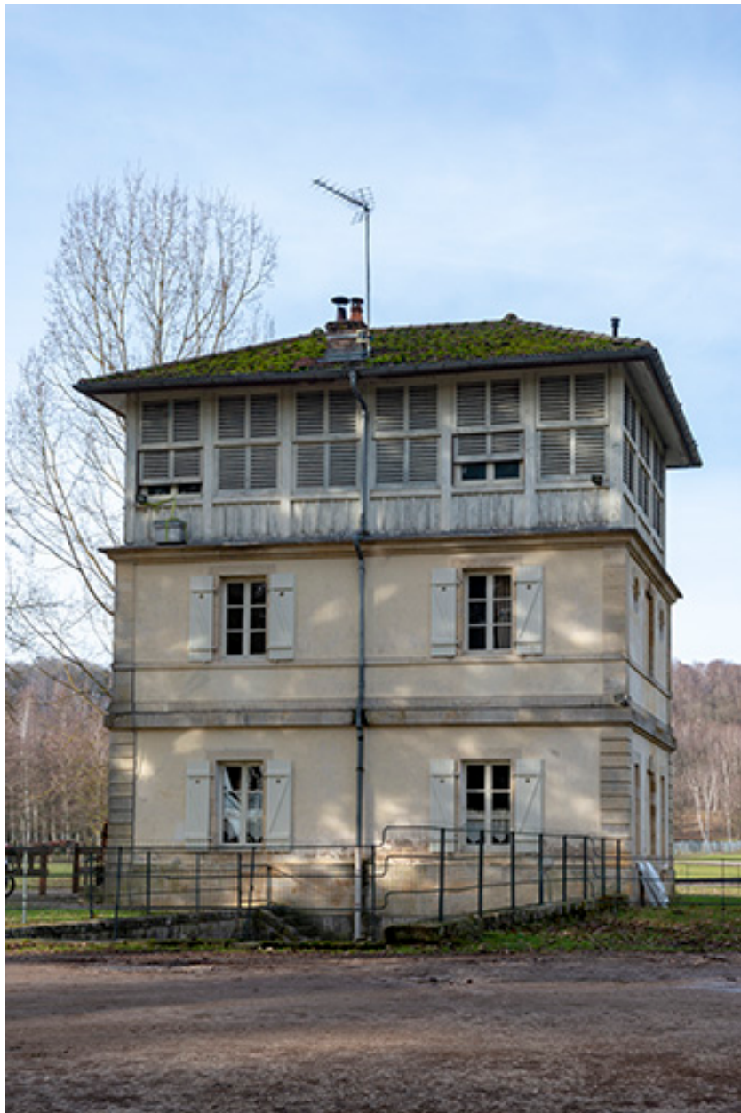
Façade sud-ouest et façade nord-ouest.
