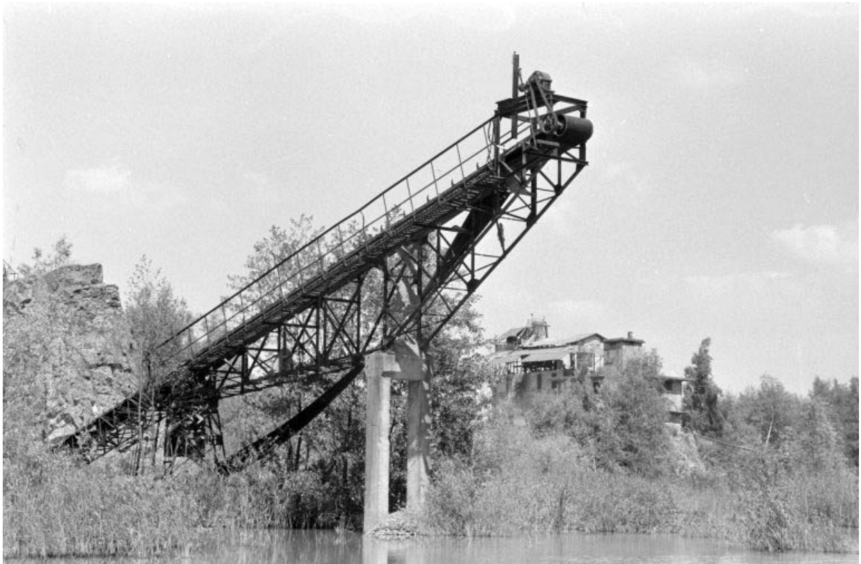
Anciennes installations vues de l'ouest, en 1988 : le transporteur.
