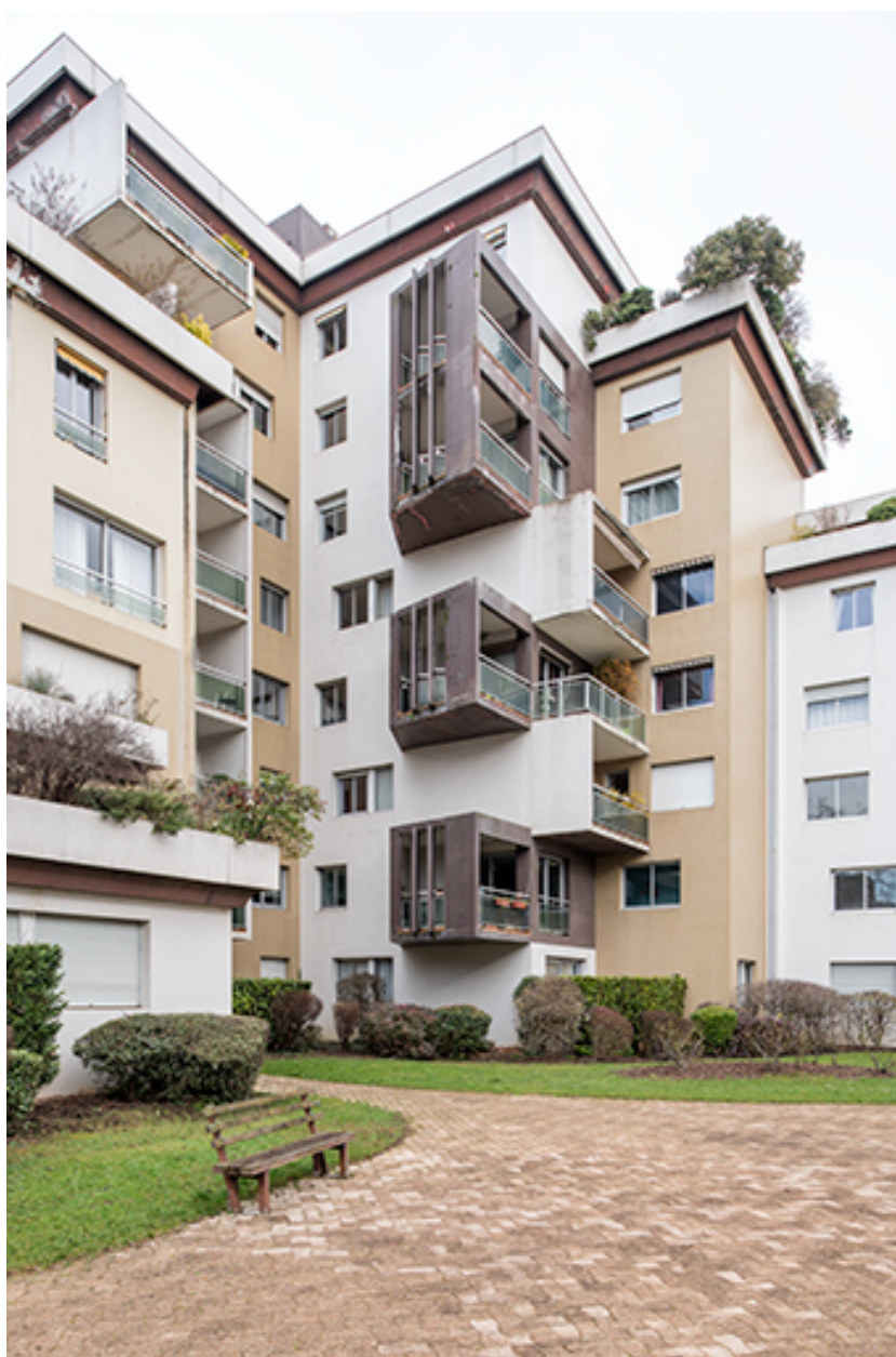
Aile sud-ouest, façade nord-ouest.
