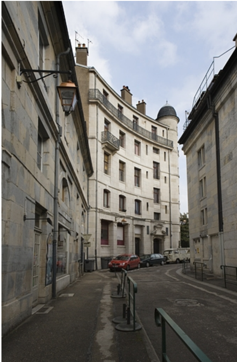
Vue d'ensemble depuis l'entrée de la rue Lacoré.
