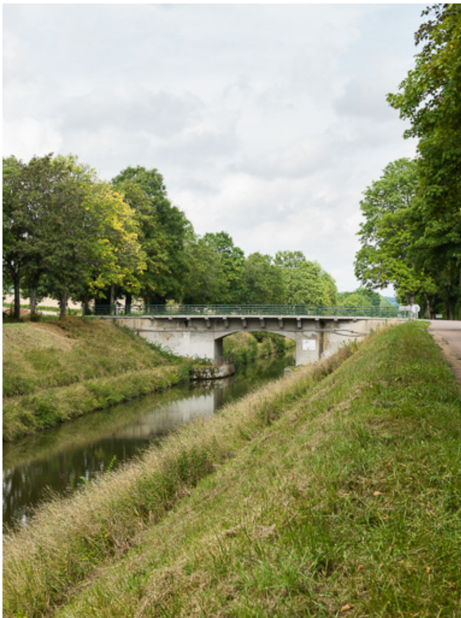
Vue d'ensemble du pont.
