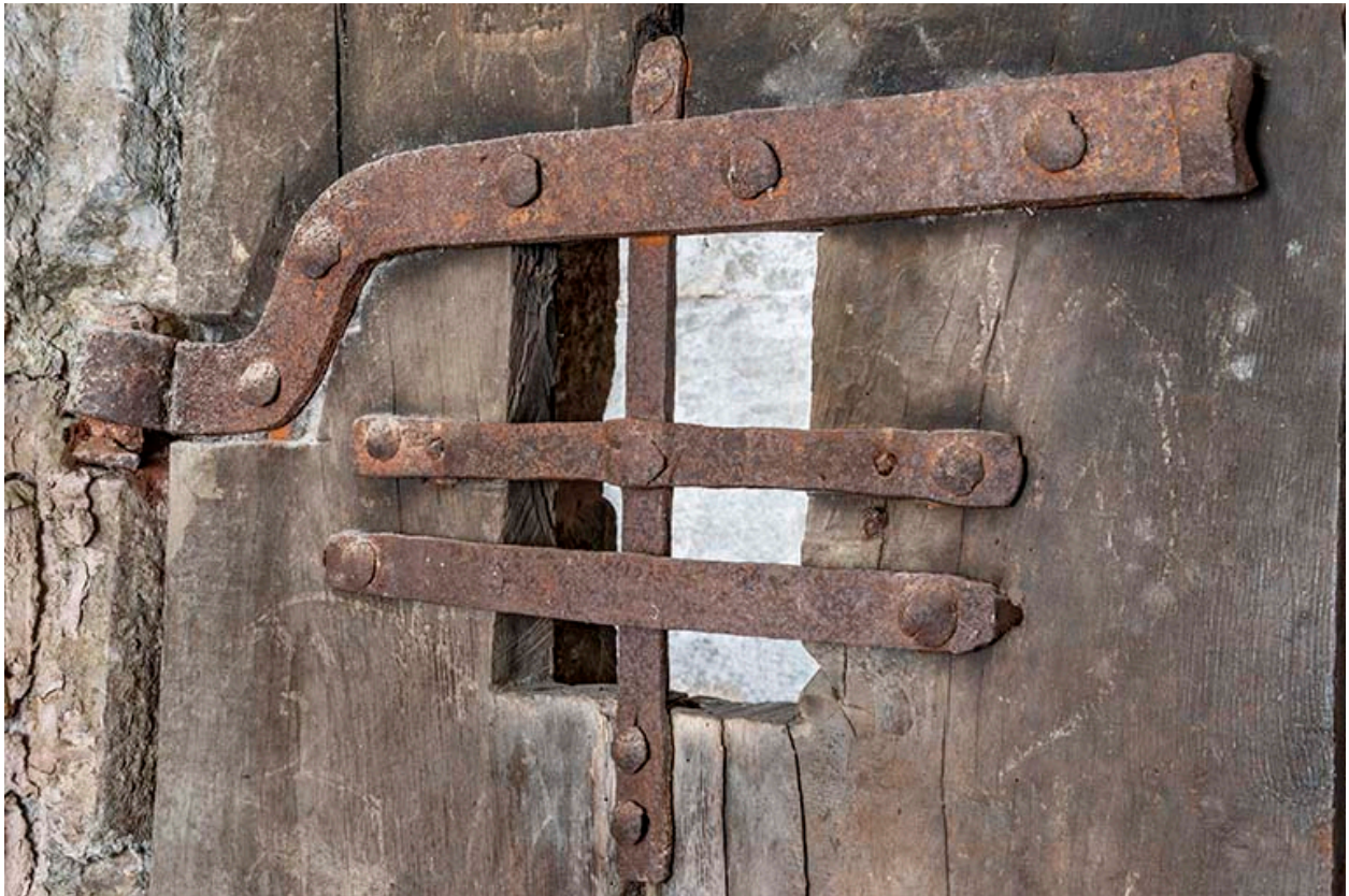
Porte de cellule. Détail d'une fenêtre ferrée.
