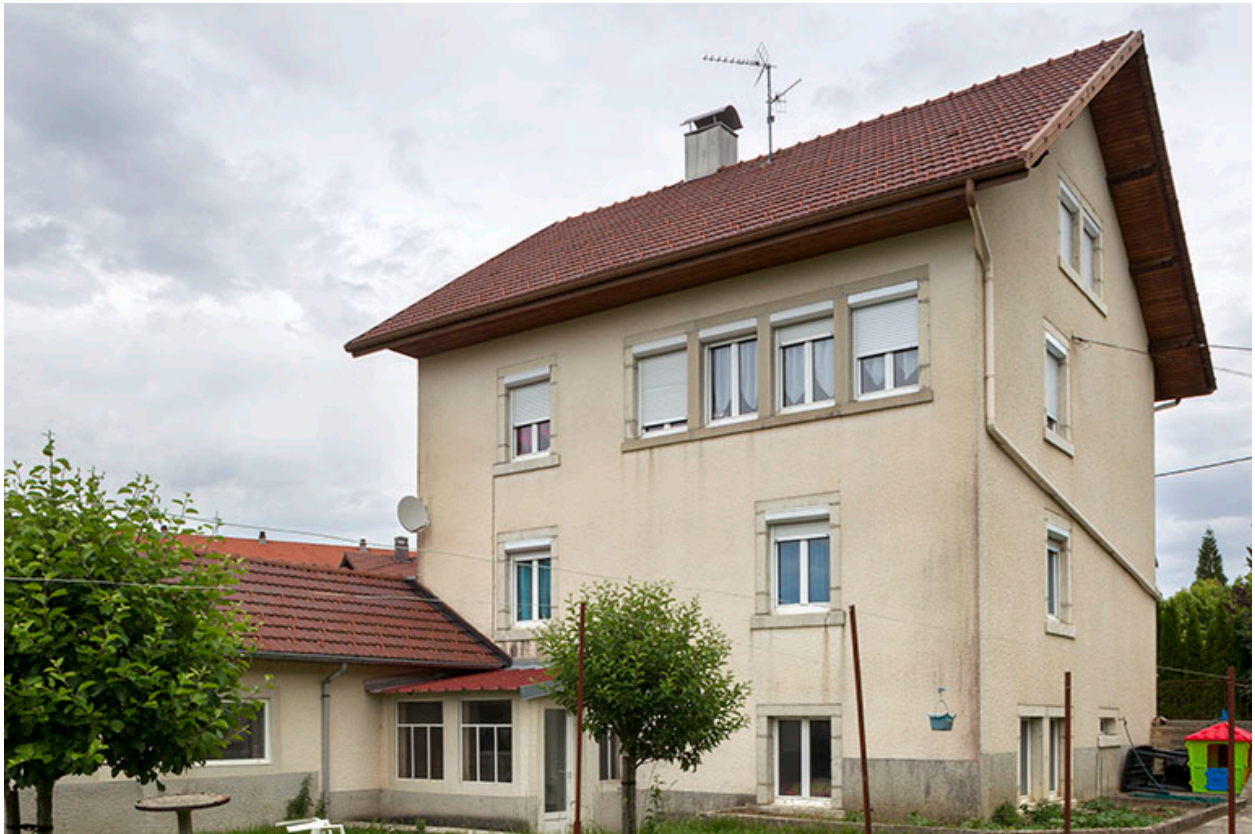
Vue d'ensemble, depuis le sud (façades postérieure et latérale gauche).
