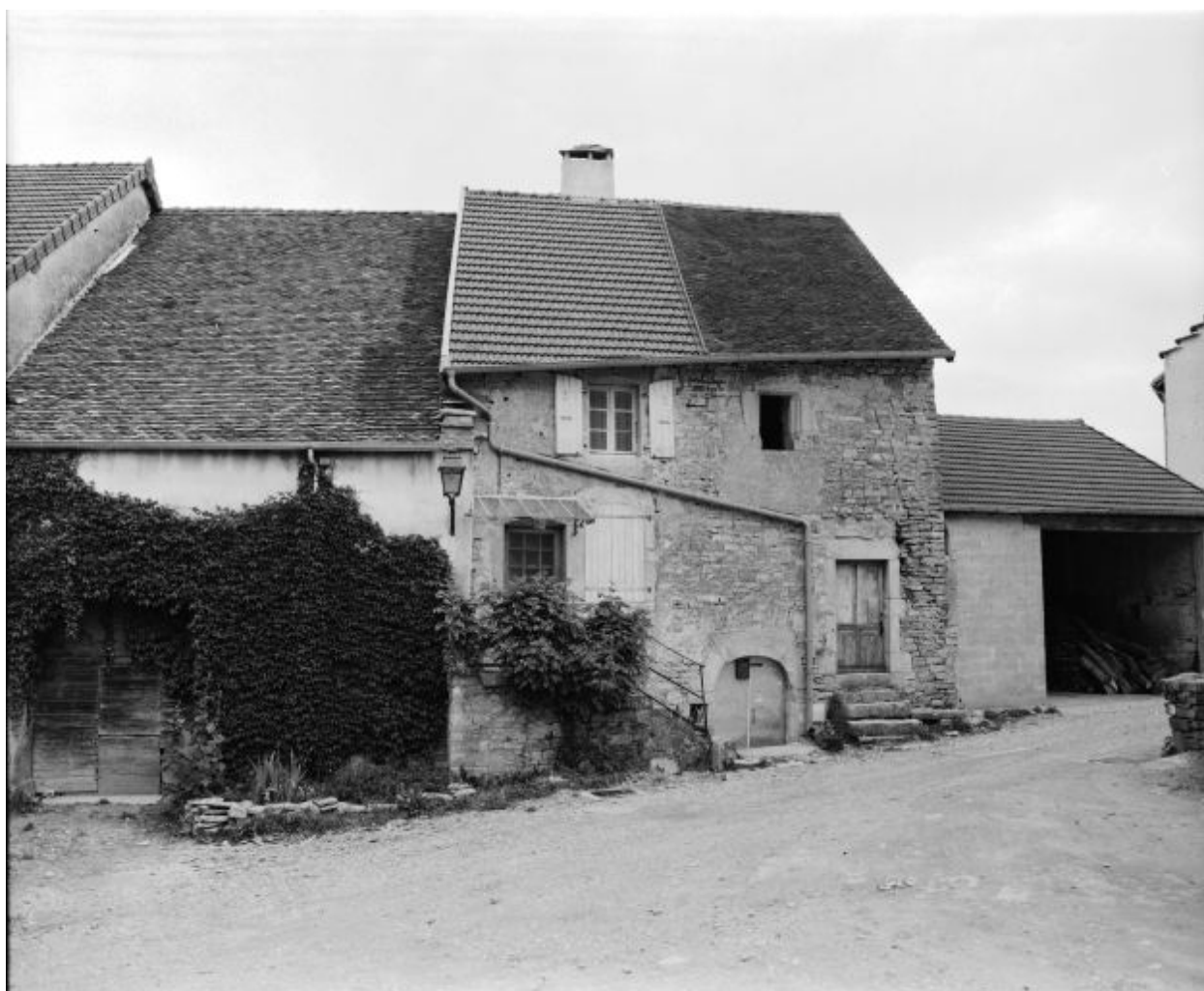
Maison située rue de l'Eglise.
