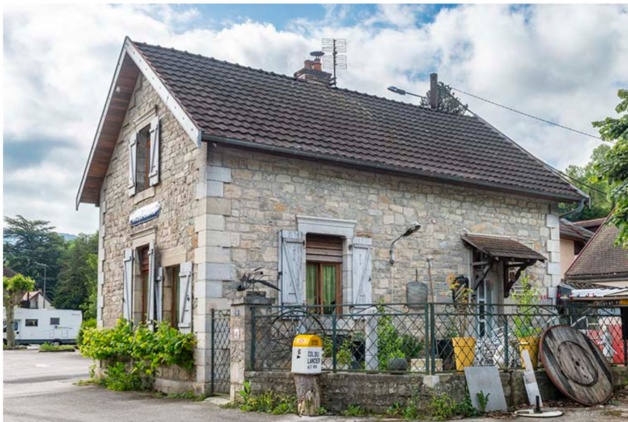
Vue depuis le nord-est.
