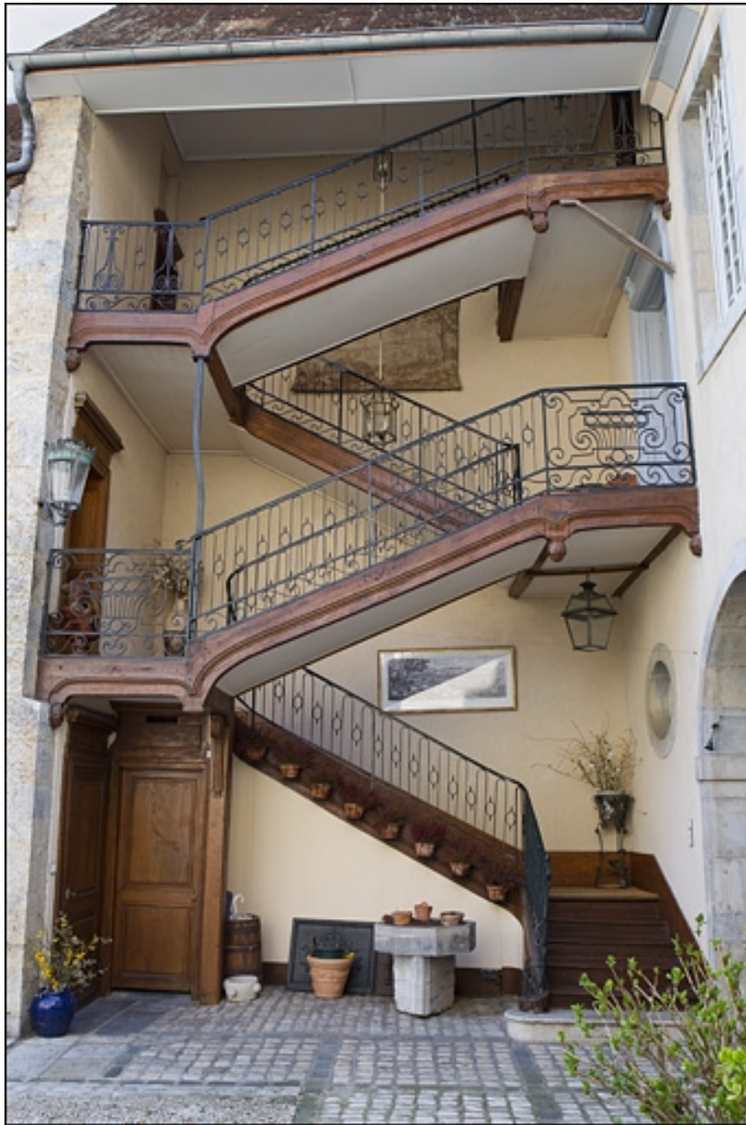
Vue d'ensemble de l'escalier à cage ouverte.
