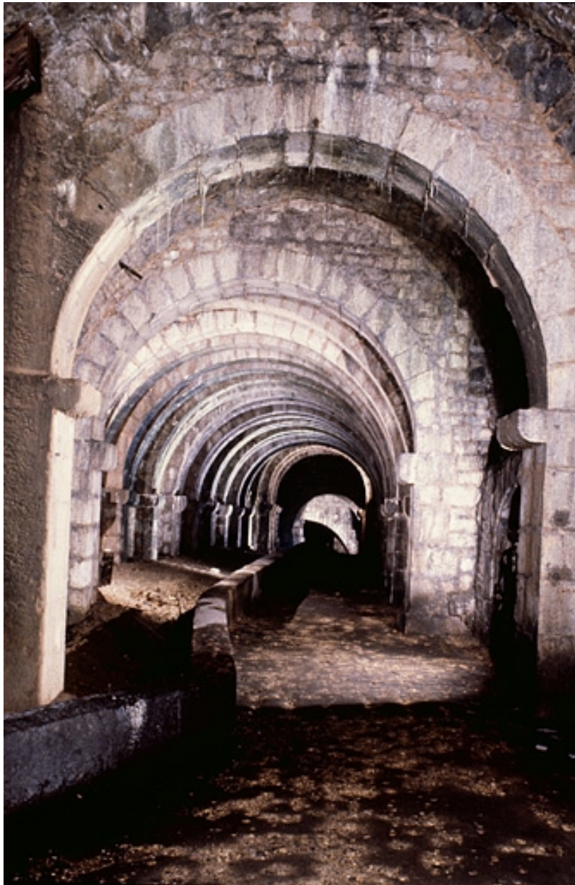
La galerie souterraine voûtée depuis le puits d'Amont.
