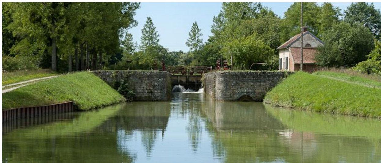
Vue du site d'écluse depuis l'aval.
