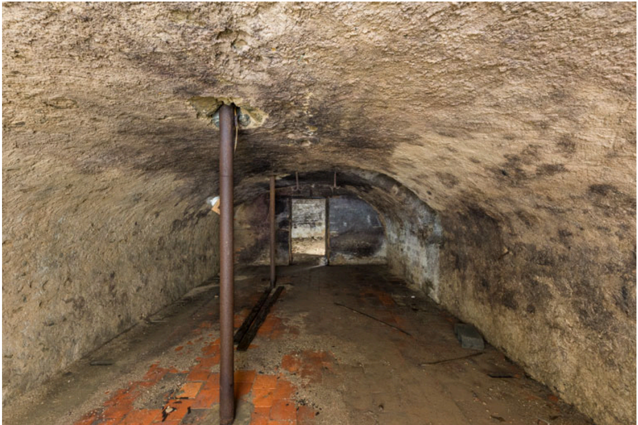
Cave voûtée sous la salle.
