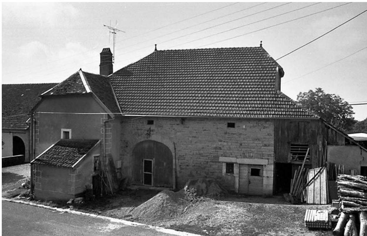
Etrelles-et-la-Montbleuse (Etrelles) : grange et écurie d'une ferme.
