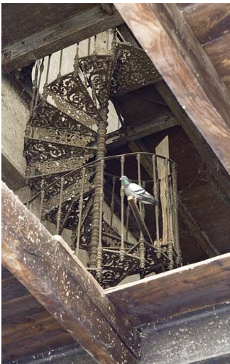
Bâtiment de rectification. Escalier intérieur en fonte.
