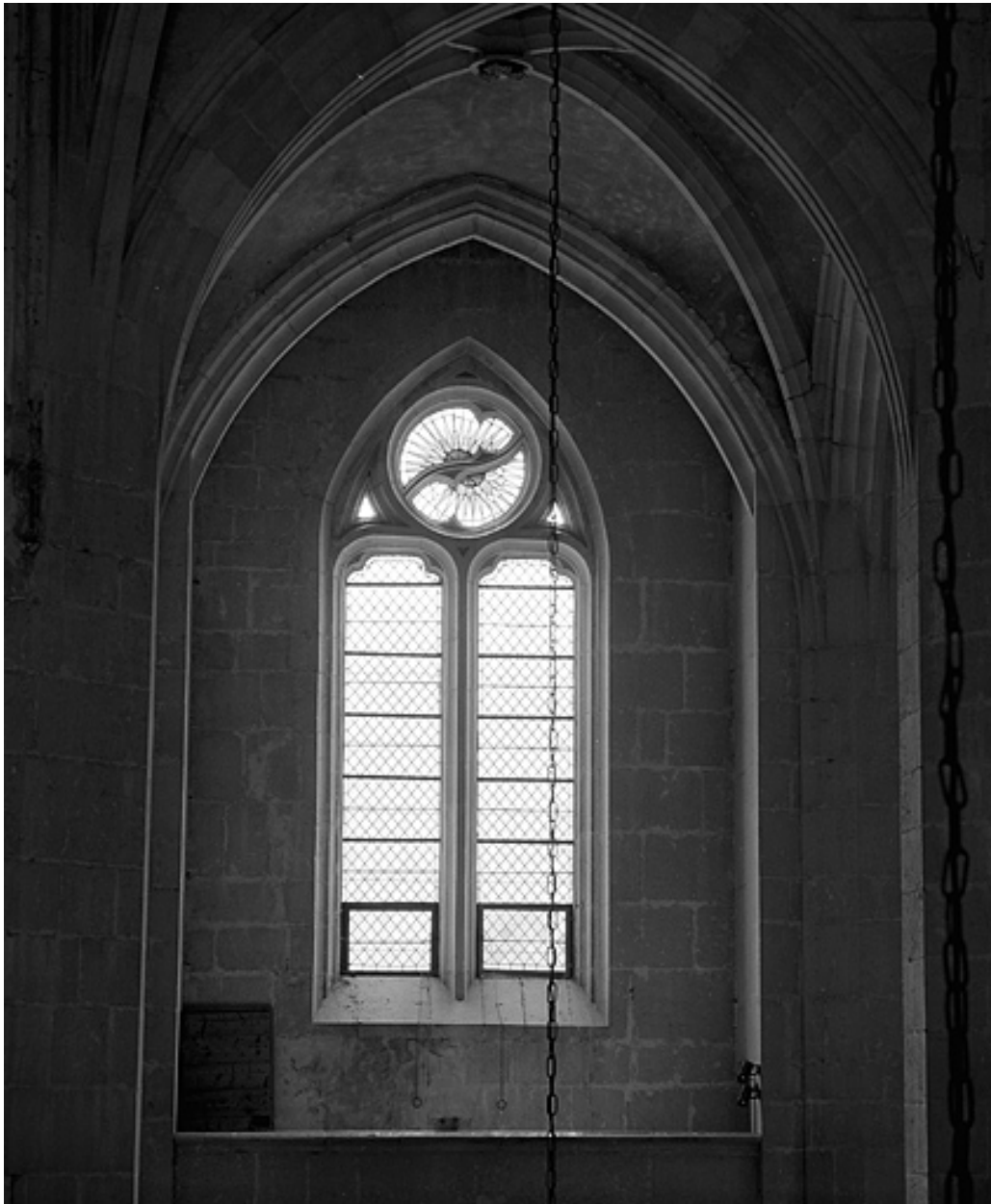
Baie de la sixième travée du collatéral sud.
