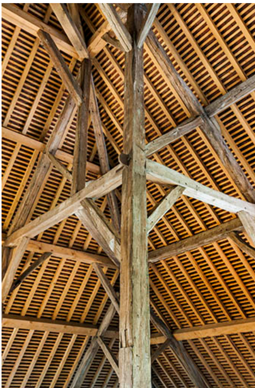
Charpente du séchoir. Détail de la croupe.
