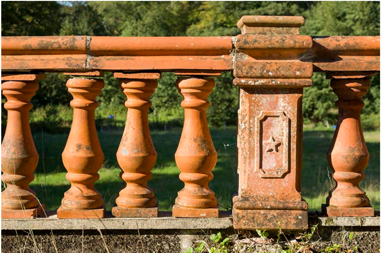
Balustrade de la terrasse, façade nord.
