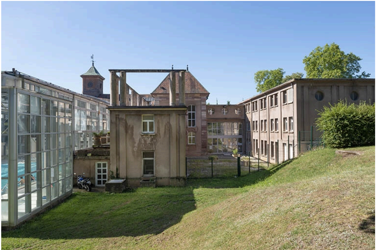
Aile ouest de la piscine couverte et prolongement du "bâtiment d'Hygie".
