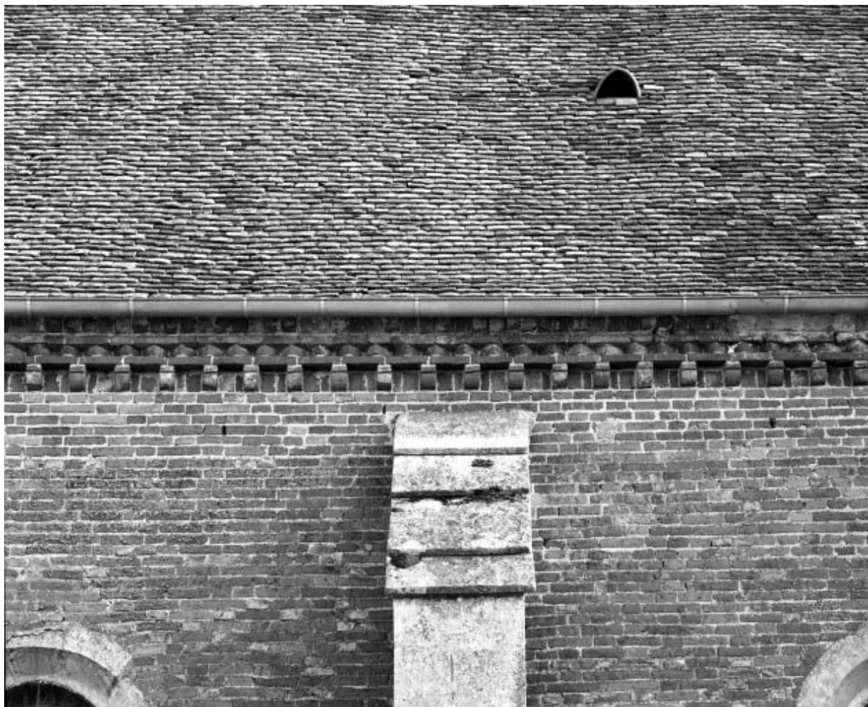
Elévation gauche, chœur, détail de la corniche
