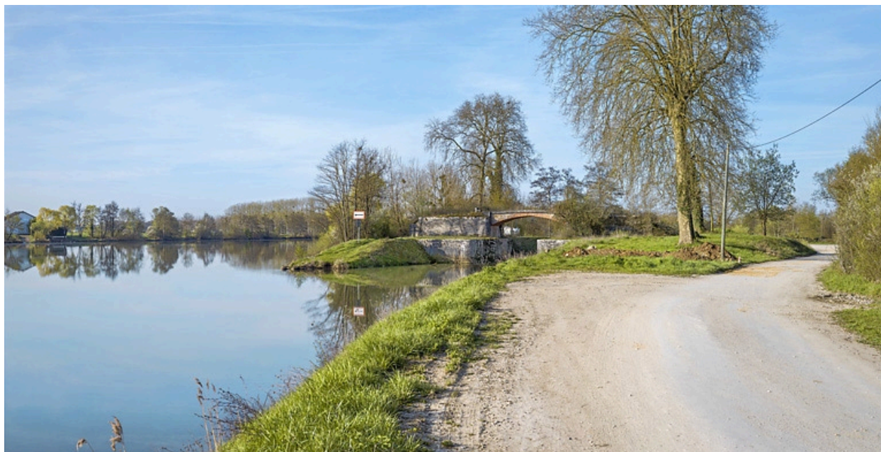
L'entrée de l'ancienne dérivation, rive droite.
