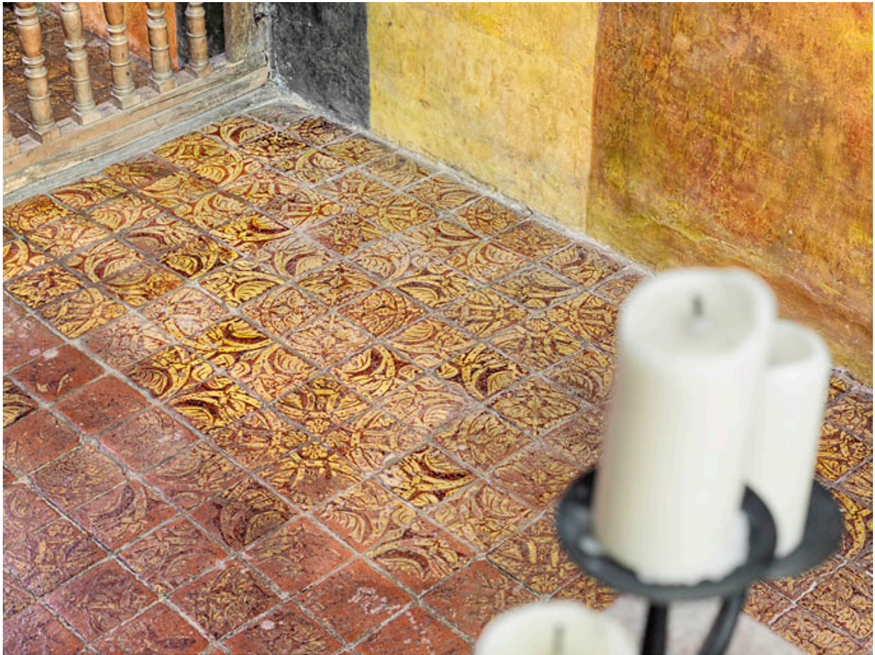
Vue d'ensemble des tapis de sol de carreaux de la chapelle.
