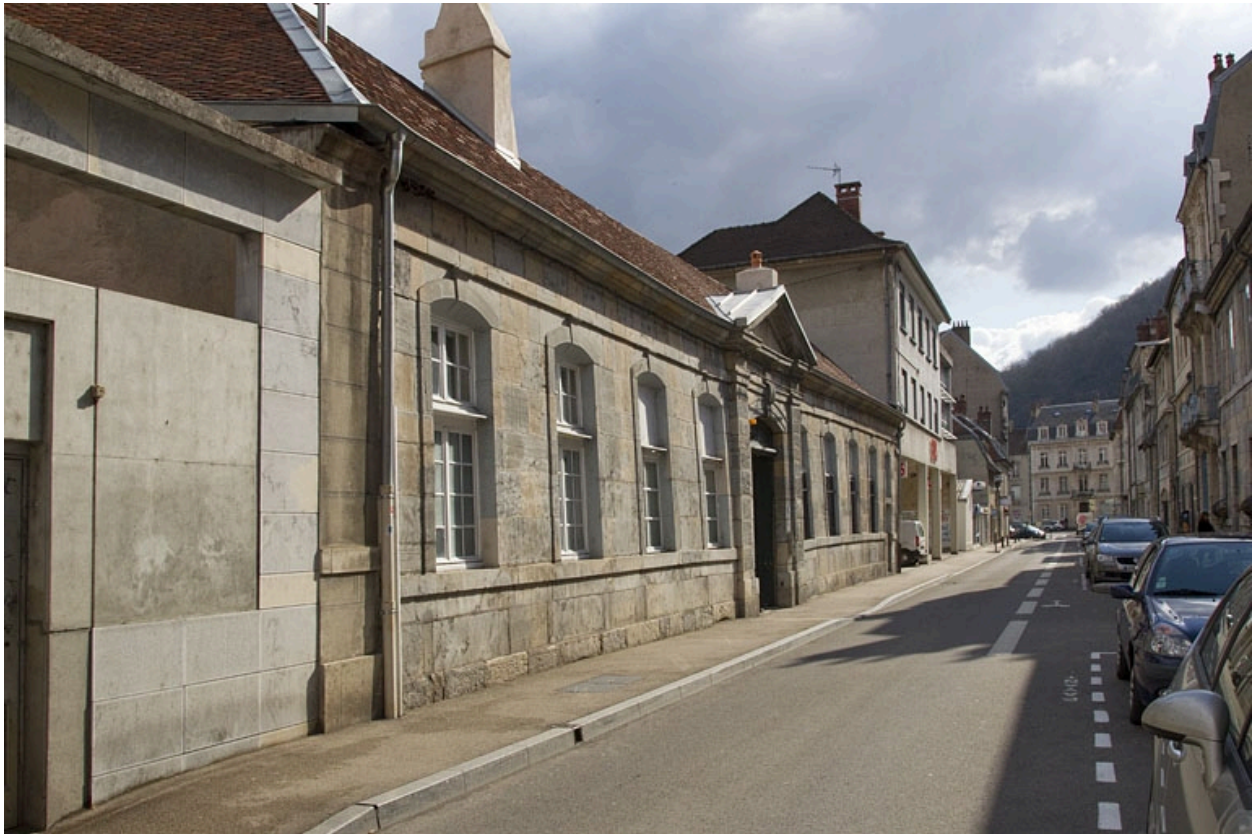
Vue d'ensemble de la clôture sur rue, de trois quarts gauche.
