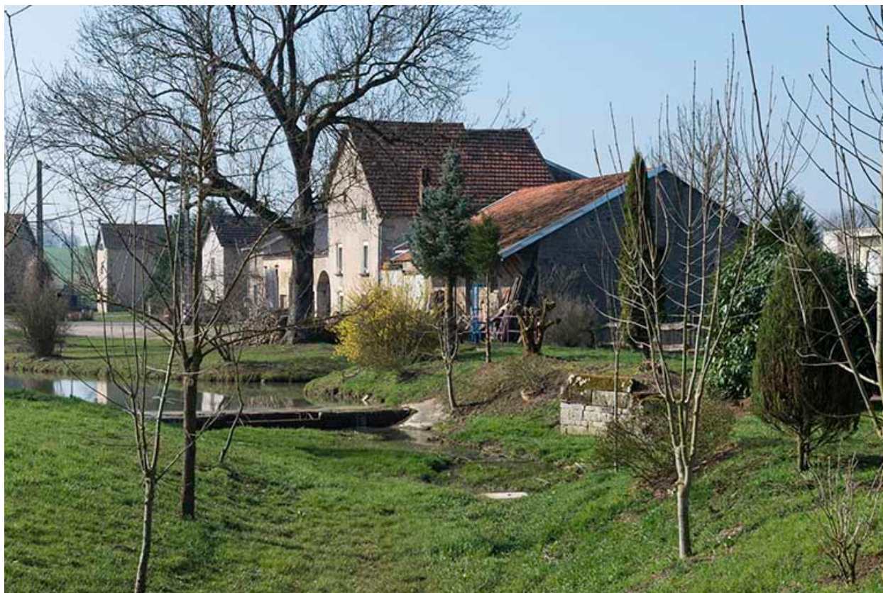
Maisons, rue du Mont.
