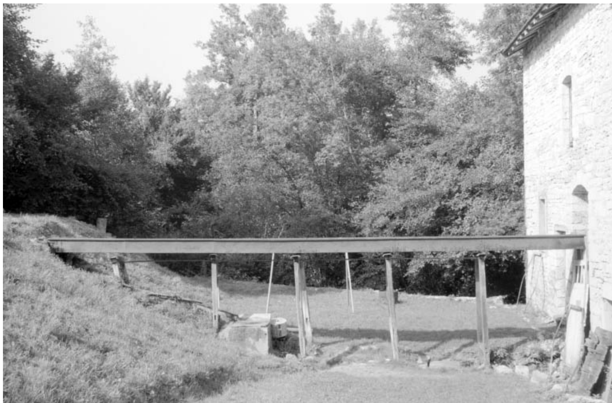
Conduite d'amenée de la roue.
