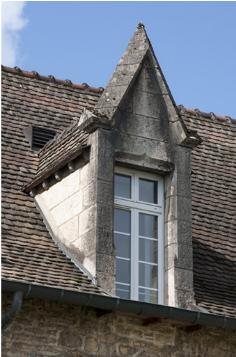
Bâtiment (C), côté jardin, détail d'une lucarne.
