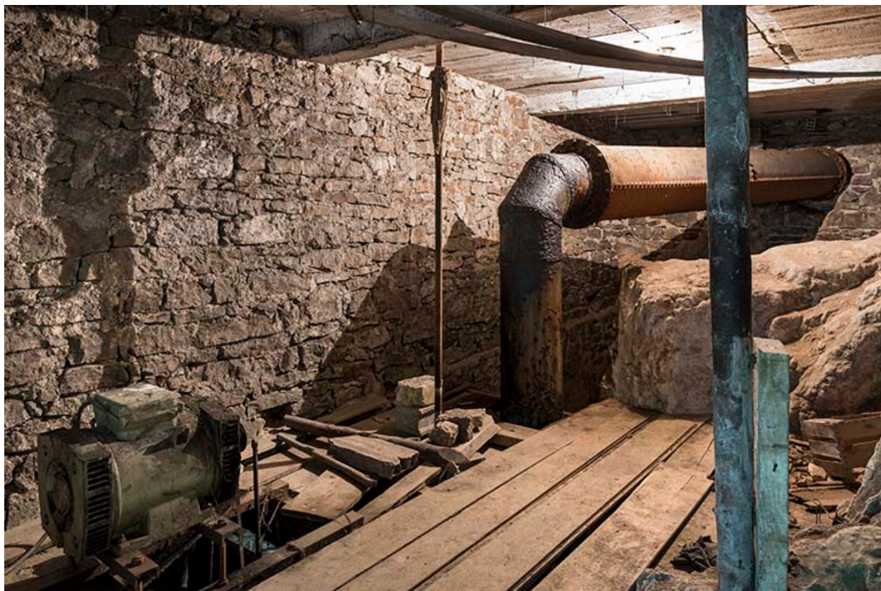
Usine : conduit d'amenée d'eau de la turbine, au 1er étage de soubassement.
