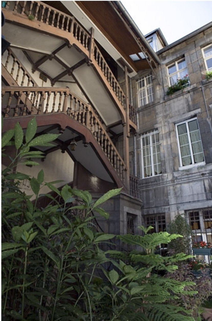
Vue de l'escalier à cage ouverte, de trois quart gauche.
