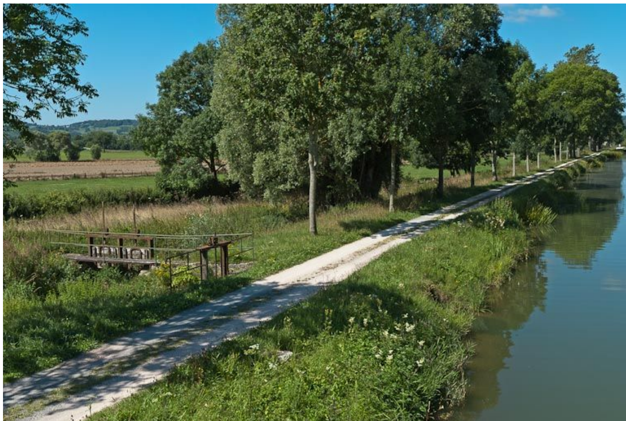
Vue des vannes de prise d'eau.
