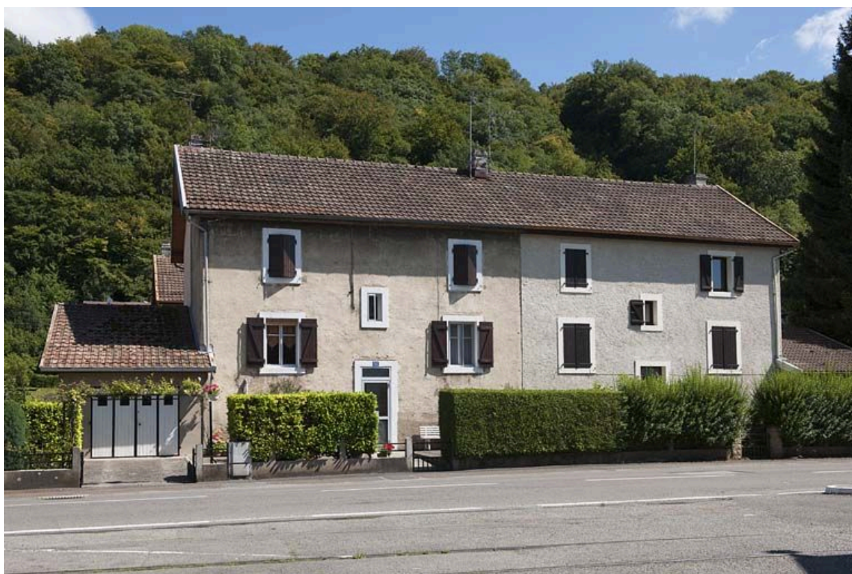
Façade ouest d'une habitation ouvrière.
