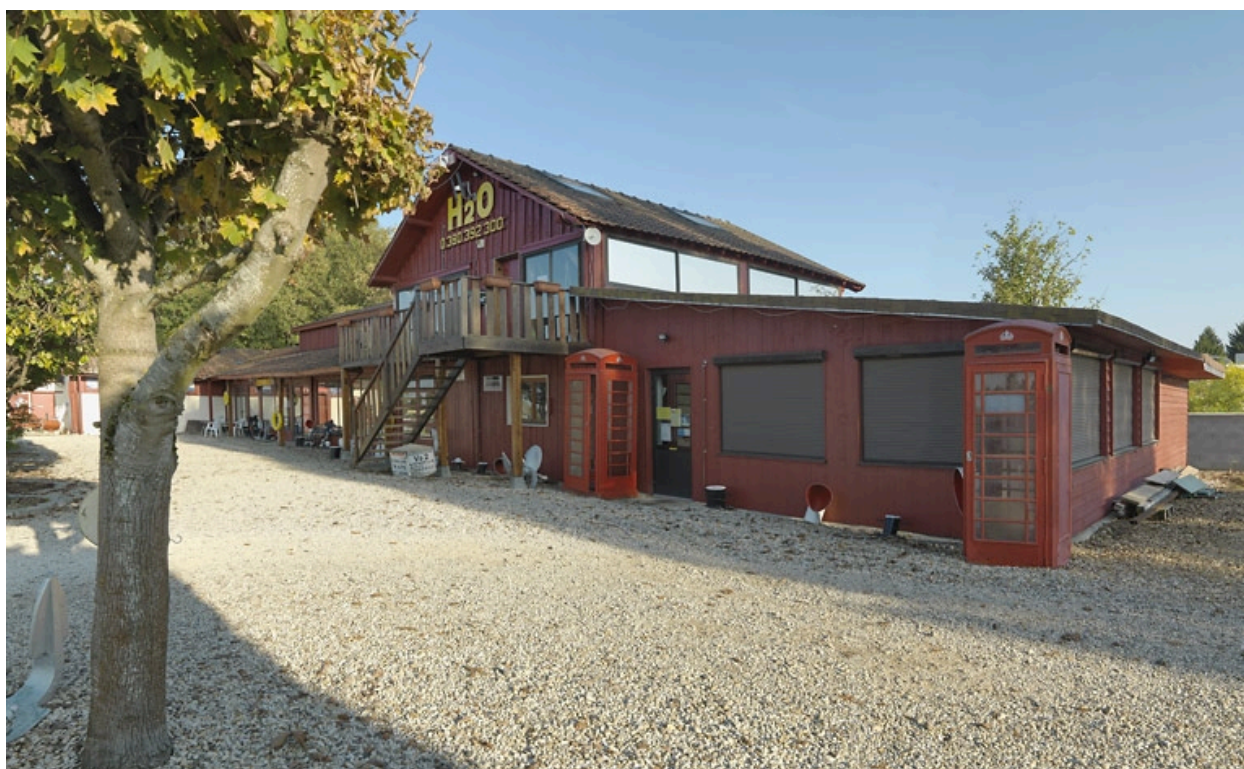
Remise transformée en capitainerie H2O.
