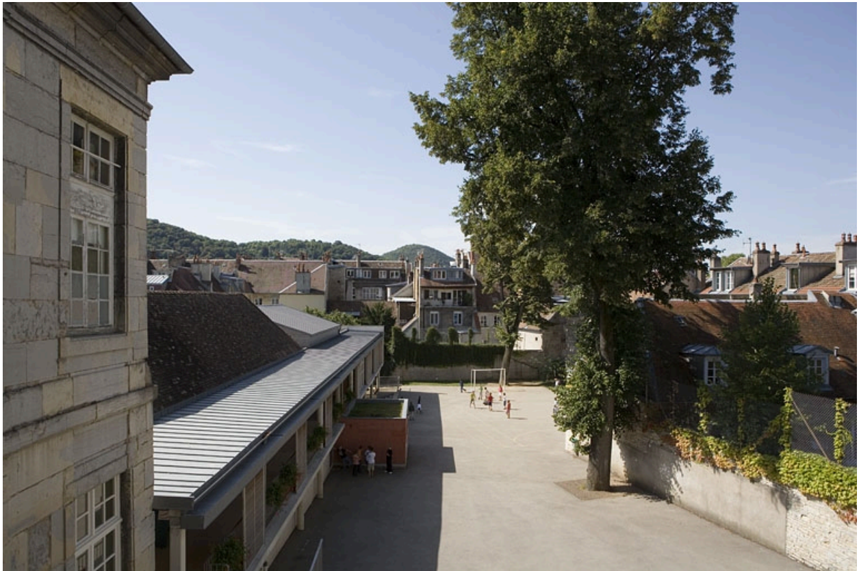
Vue d'ensemble de la cour de l'école, à l'emplacement de l'ancien jardin.
