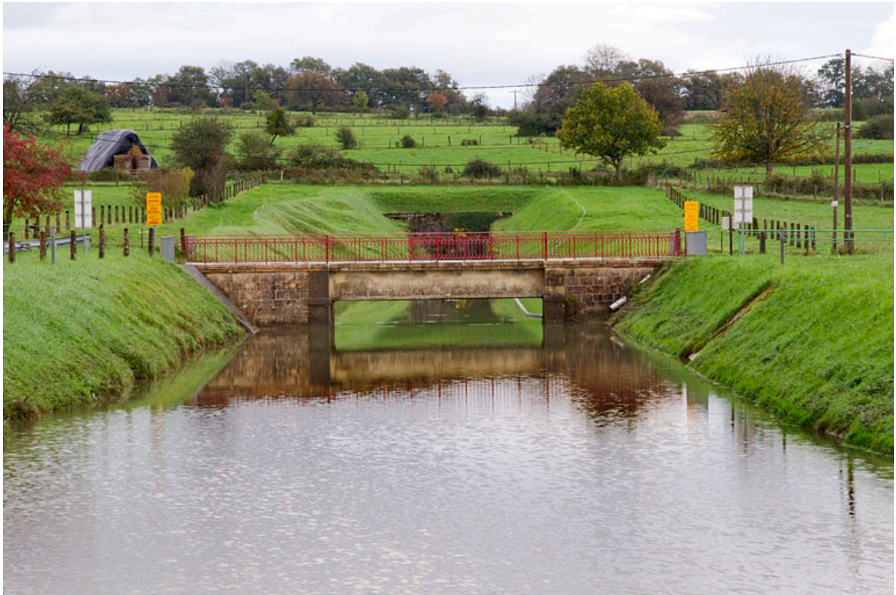
Pont routier sur le bief d'amenée.
