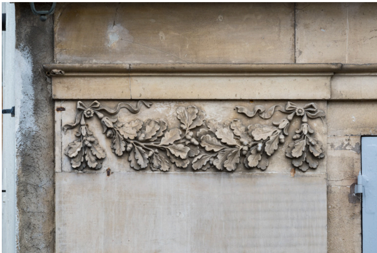
Façade latérale gauche, 1er pilastre (à gauche) : guirlande sculptée.
