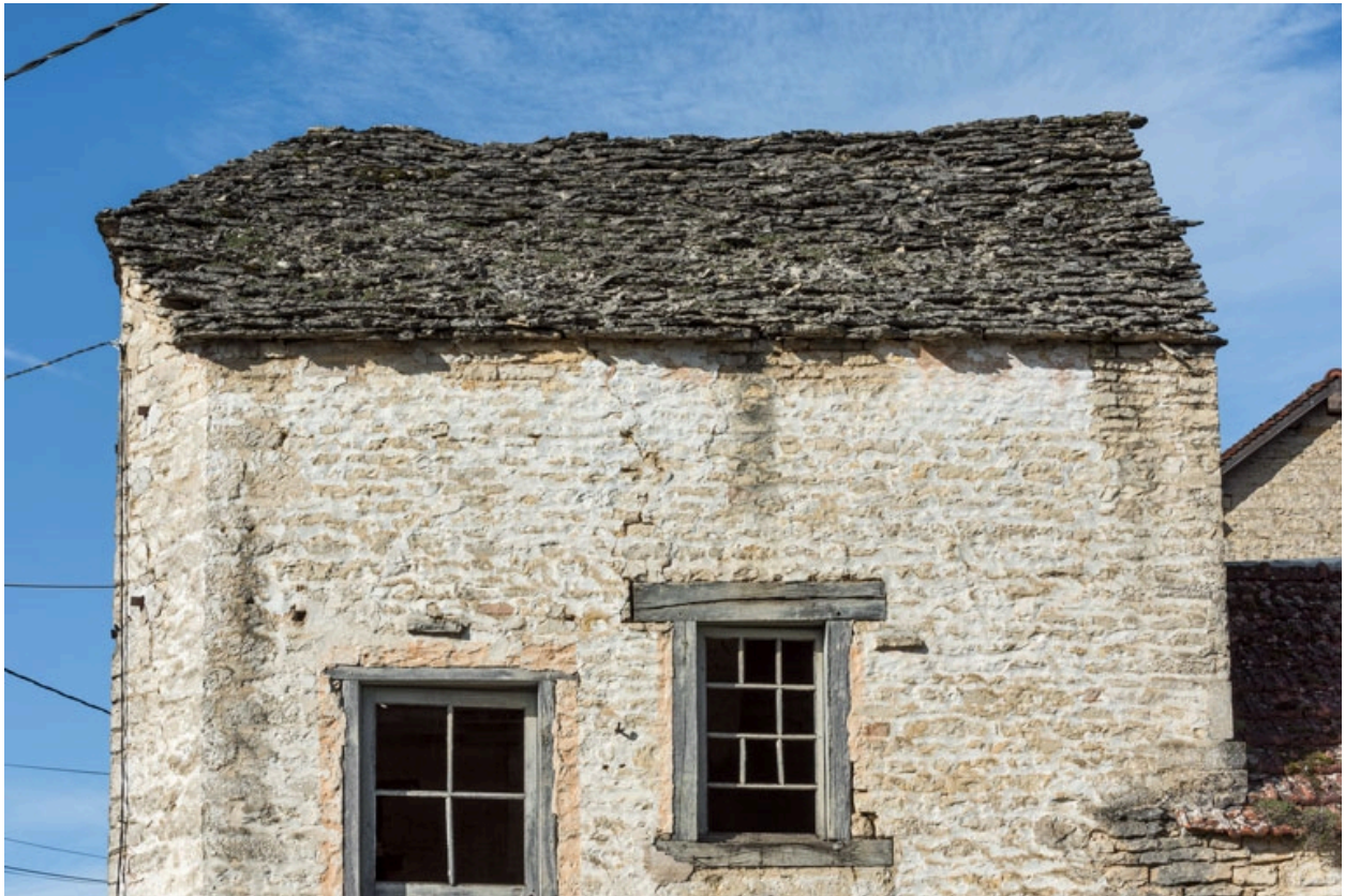
Détail de la toiture côté est.
